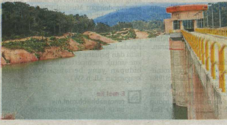
Projek penyambungan paip dari Empangan Triang ke LRA Ngoi-Ngoi di Pantai, Seremban, sudah siap dan dijangka beroperasi Jumaat ini.
